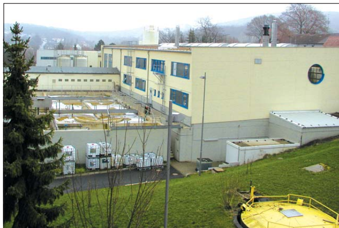
Seit nunmehr zwei Jahren in Betrieb: die neue ZEA in Iserlohn.
