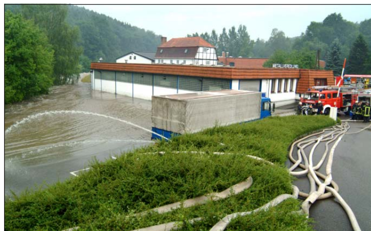
Komplett überflutet wurde das Gelände des Iserlohner Galvanik-Betriebes. Die Feuerwehren waren sofort zur Stelle. (Foto: May/IKZ)
