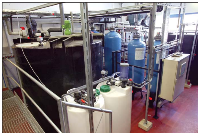
In einer speziellen Reinigungsanlage werden in der ZEA Iserlohn abgearbeitete Chromsäuren wieder neu aktiviert.
